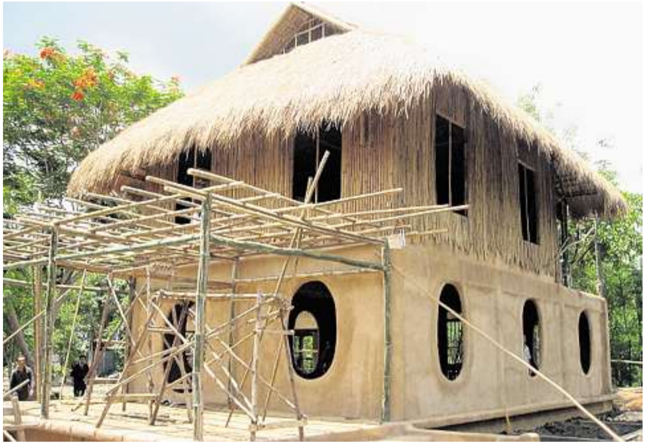
Bald fertig gebaut: Das Schulhaus der «Lotus Flower Foundation». Weiter entstehen ein Haus mit Schlafsaal, Kantine und Küche sowie ein kleines Personalhaus. Bild Lotus Flower Foundation
